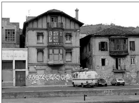
FIGURA 1. VIVIENDAS OKUPAS EN MARGEN DERECHA DE LA RÍA DEL NERVIÓN, EN BILBAO. EN ESTA ZONA DE RECONVERSIÓN INDUSTRIAL SE INICIARON MUCHAS OKUPACIONES DESDE FINALES DE LA DÉCADA DE LOS OCHENTA. EN LA ACTUALIDAD HAY MÁS DE 20 VIVIENDAS Y UNOS 5 CENTROS SOCIALES (GAZTETXES) A AMBOS LADOS DE LA RÍA. FOTO: MIGUEL MARTÍNEZ.
